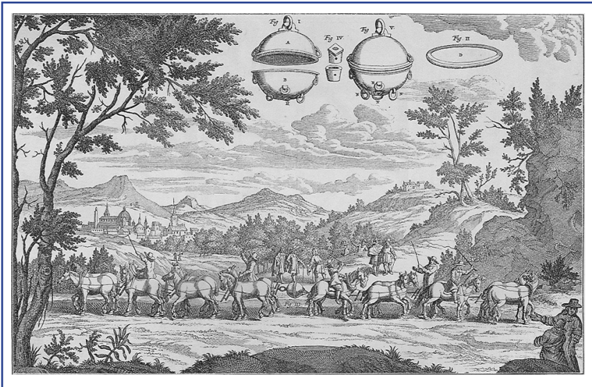
Grabado que muestra el experimento que, en 1656, O. von Guericke llevó a cabo en Madenburgo, su lugar de origen, para demostrar la existencia del vacío.
